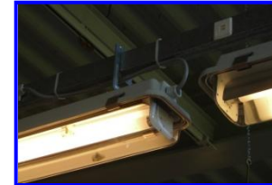
Kabelverschraubungen in Leuchtgehäusen Knickschutz für flexible Anwendungen.
